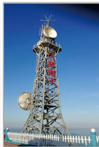
北隍岛安装防雷设备实景图
