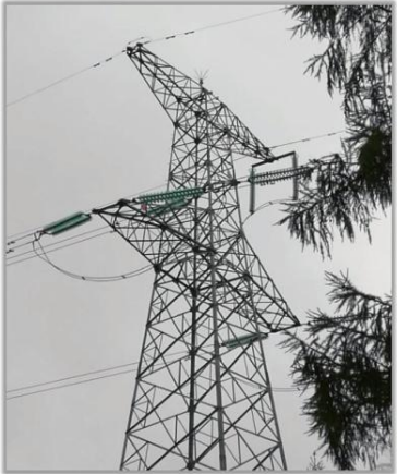
高压输电线路安装防雷设备实景图
